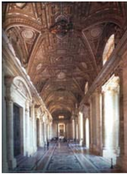
Veduta dell'Atrio dopo il restauro
