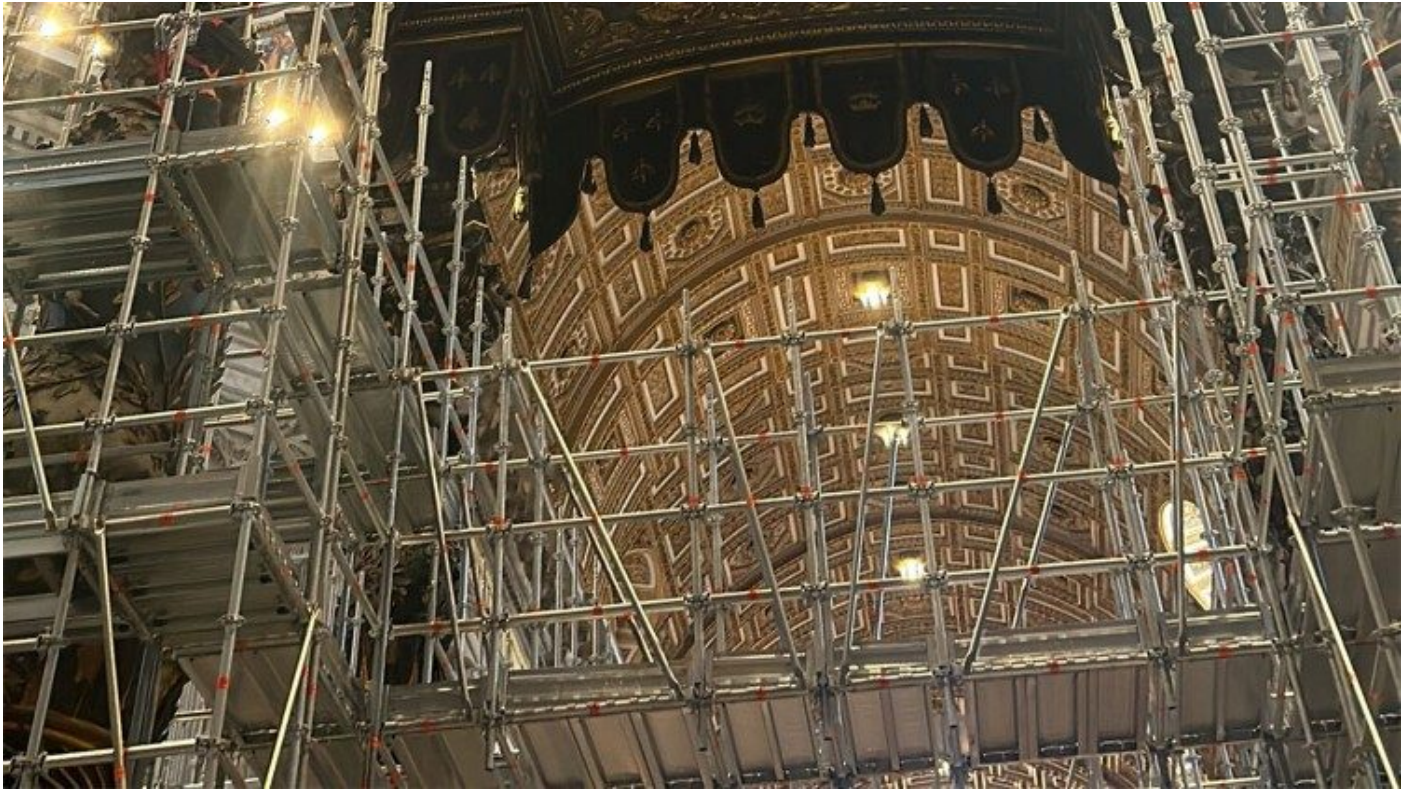
L'impalcatura intorno al Baldacchino del Bernini
